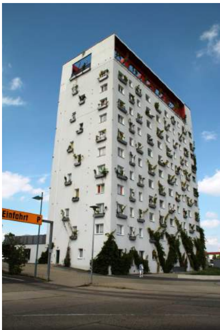
Abb. 4: Andere Gebäude werden aufwändig saniert und neu in Wert gesetzt
